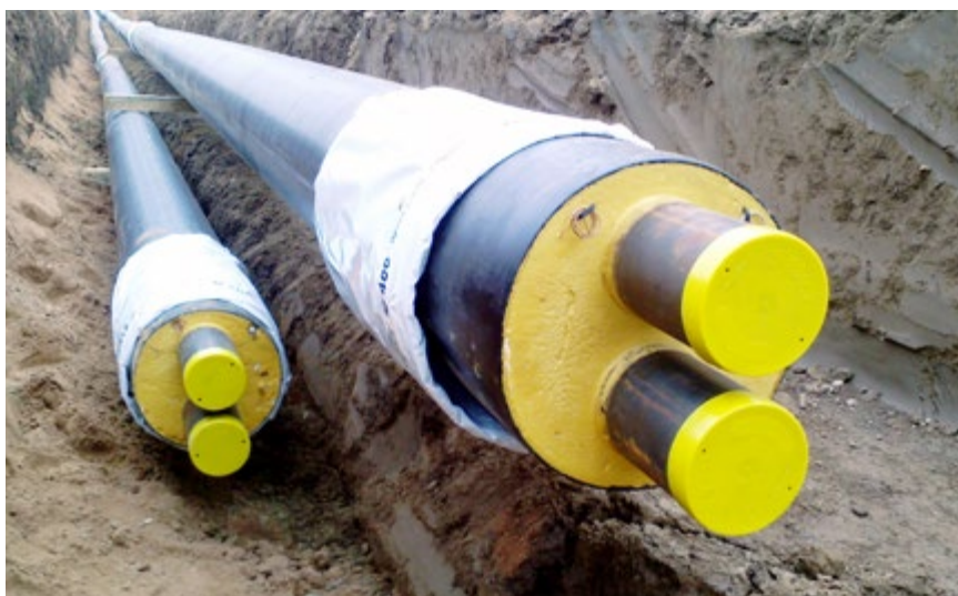
DIE LEITUNGEN FÜR DAS WÄRMENETZ WERDEN VERLEGT
