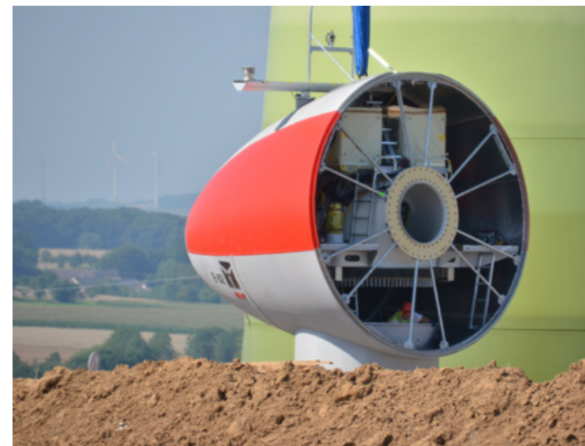
19 Tonnen auf dem Weg nach oben: Das Maschinenhaus wird gehoben.
