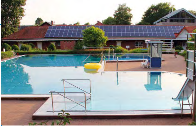
PHOTOVOLTAIK AUF DEM DACH DES FREIBADES IN HAMMINKELN.
