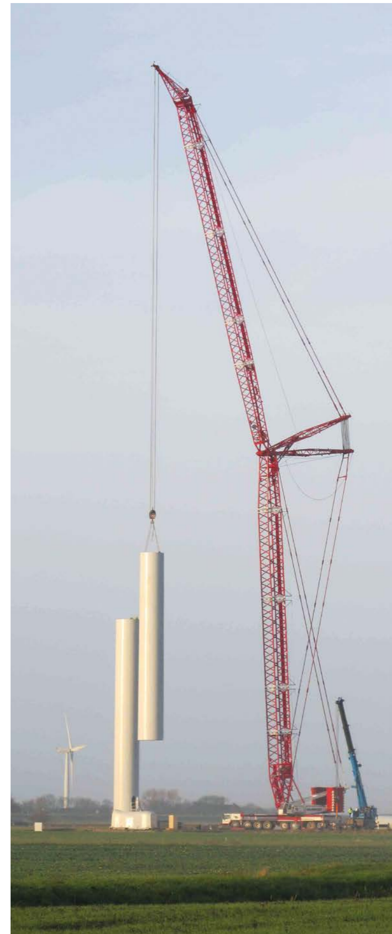
DIE ERSTEN WINDENERGIEANLAGEN IN BORDELUM WURDEN BEREITS REPOWERED.
