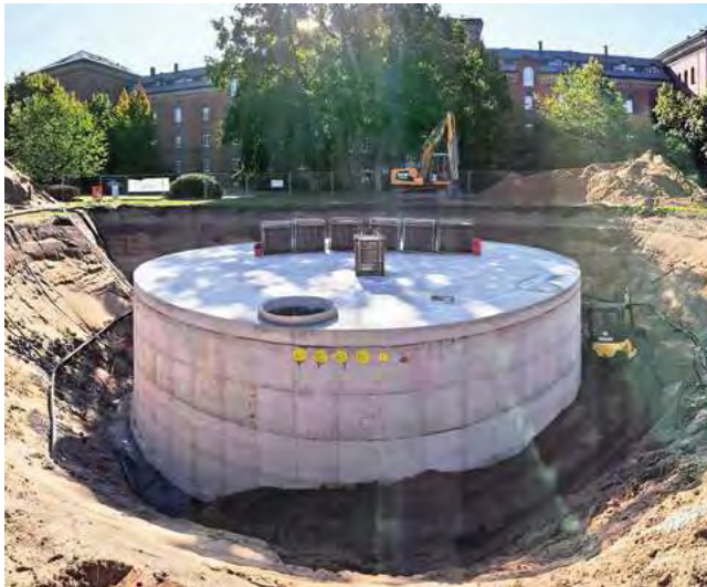
Es klingt paradox: Der Eisspeicher in Rendsburg macht aus Eis Wärme für ca. 200 Haushalte.
