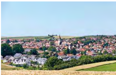
Ilsfeld macht aus Abwasser Wärme für 250 Haushalte Quelle: Gemeinde Ilsfeld
