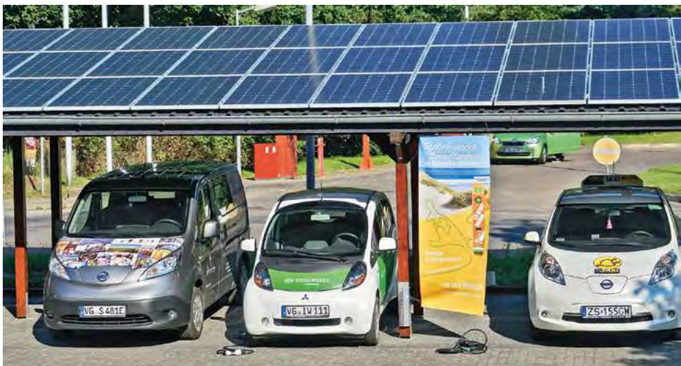
Im Kaiserbad Ahlbeck auf Usedom kann Strom direkt vom Dach eines Carports getankt werden Quelle: Inselwerke eG
