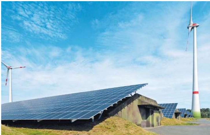
Das ehemalige Munitionsdepot in Saerbeck wurde zu einem Bioenergiepark umfunktioniert. Quelle: Gemeinde Saerbeck
