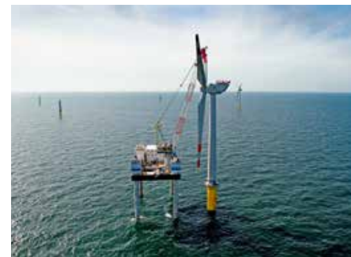
Offshore-Montage eines Rotorsterns Quelle: DOTI / Matthias Liebeler
