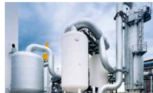
Tankbehälter für flüssigen Wasserstoff Quelle: Hypos
