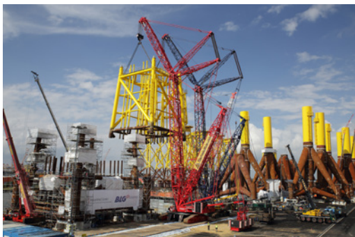
Die Bauarbeiten am Offshore-Terminal Bremerhaven gehen voran. Quelle: bremenports GmbH & Co. KG
