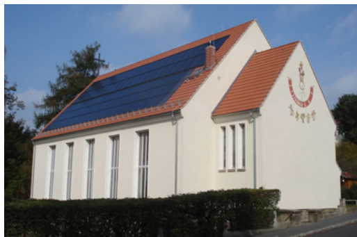
Trotz Wärmedämmung konnten viele stilprägende Elemente des Gebäudes erhalten werden. Quelle: Laurentiuskirchgemeinde
