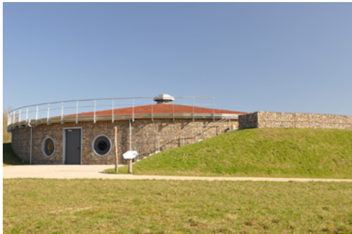
Der Multifunktionspeicher auf dem Gut Karlshöhe solarisiert das Fernwärmeverbundnetz Hamburgs mit regenerativer Wärme. Quelle: Hamburger Klimaschutzstiftung
