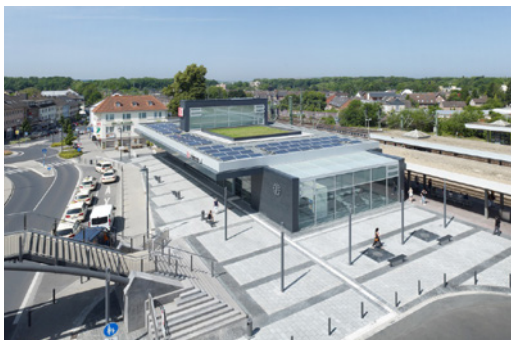
Der erste „Grüne Bahnhof“ Deutschlands in Horrem hat eine begrünte Dachfläche, die die Toilettenspülung mit dem aufgefangenen Regenwasser versorgt.
