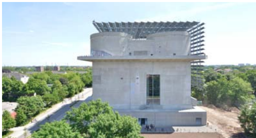
Der Hamburger Energiebunker dient heute als regeneratives Kraftwerk für Strom und Wärme sowie als Großwärmespeicher für ein anliegendes Wohnviertel. Quelle: IBA Hamburg GmbH/Martin Kunze
