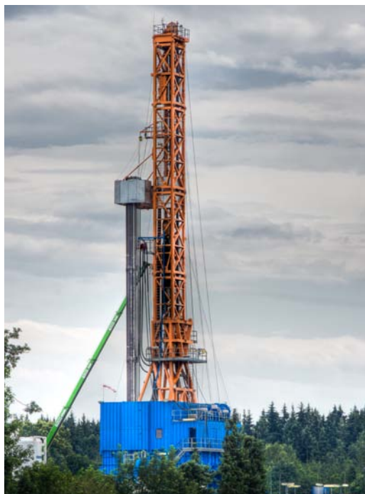
Bohrturm eines Tiefengeothermieprojekts in Taufkirchen bei München Quelle: Daldrup & Söhne AG
