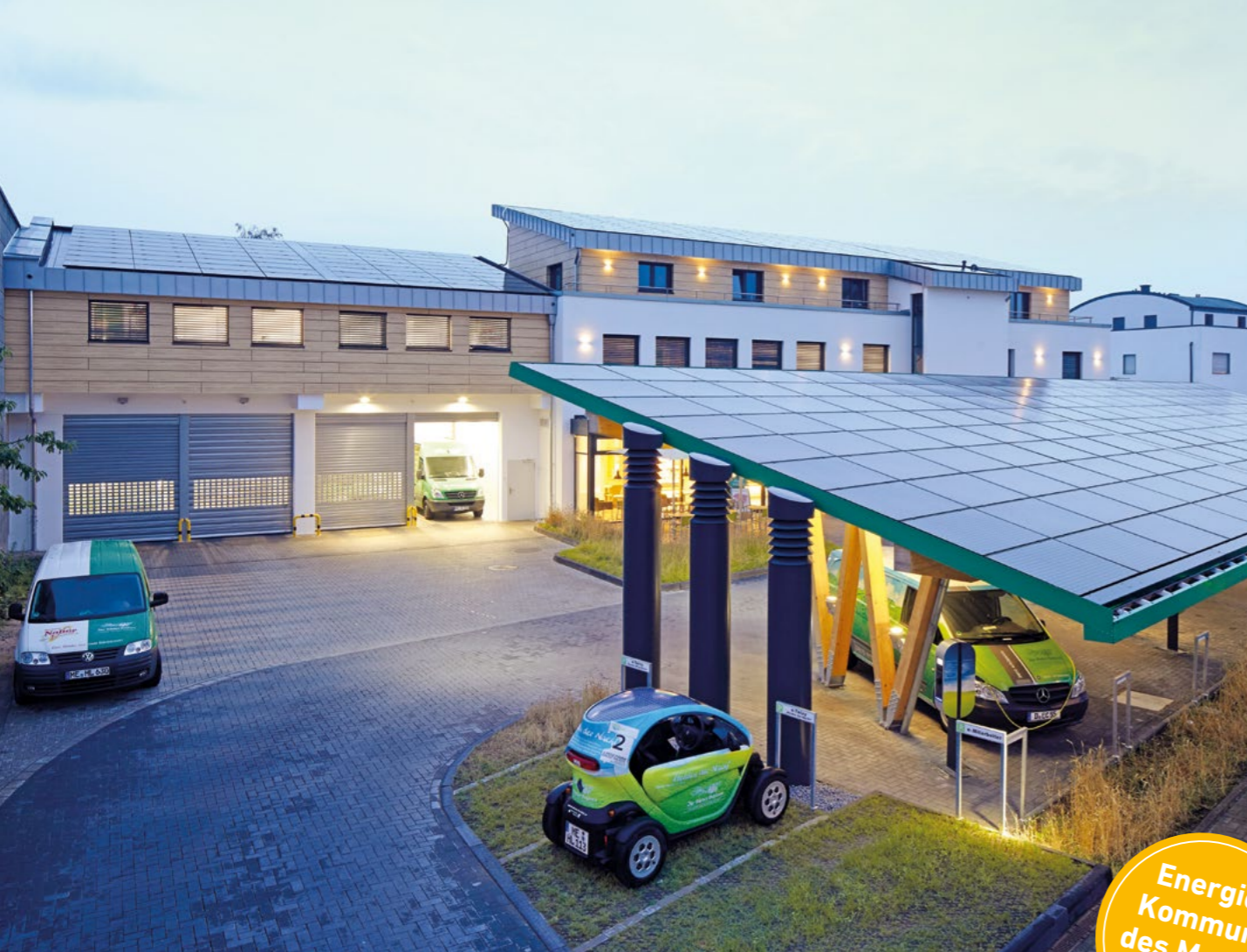
SOLARANLAGE AUF DEM DACH DES CARPORTS DER BACKSTUBE
