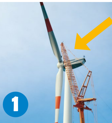
Der Rotor wird am Kran befestigt...
