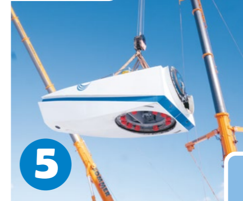
so wird die Gondel heruntergelassen
