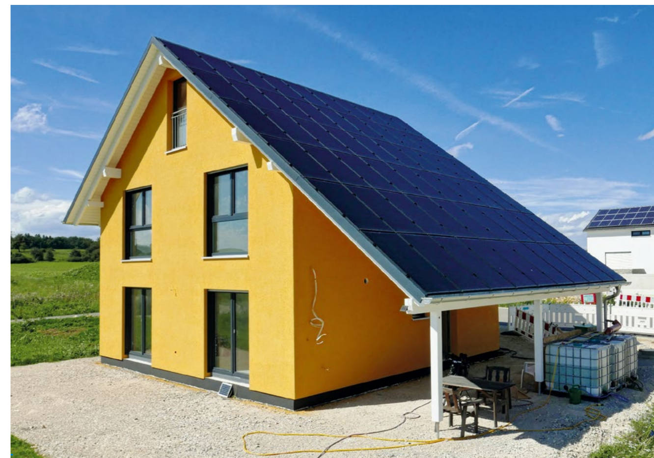
LUFTGEKÜHLTES PVT-INDACH-SYSTEM MIT STANDARD PV-MODULEN
