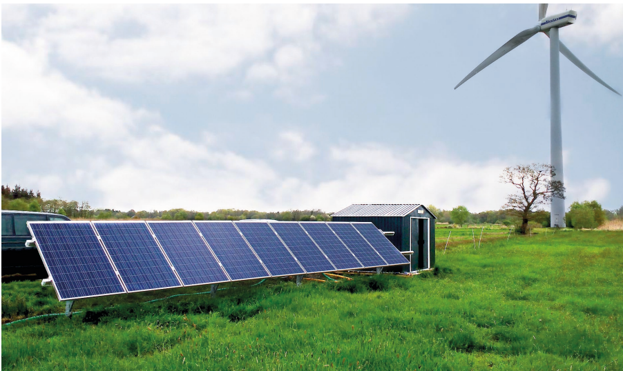
Wasserstandsregulierung mit Solarpumpen auf einer Moorfläche. Quelle: Wagner Solar
