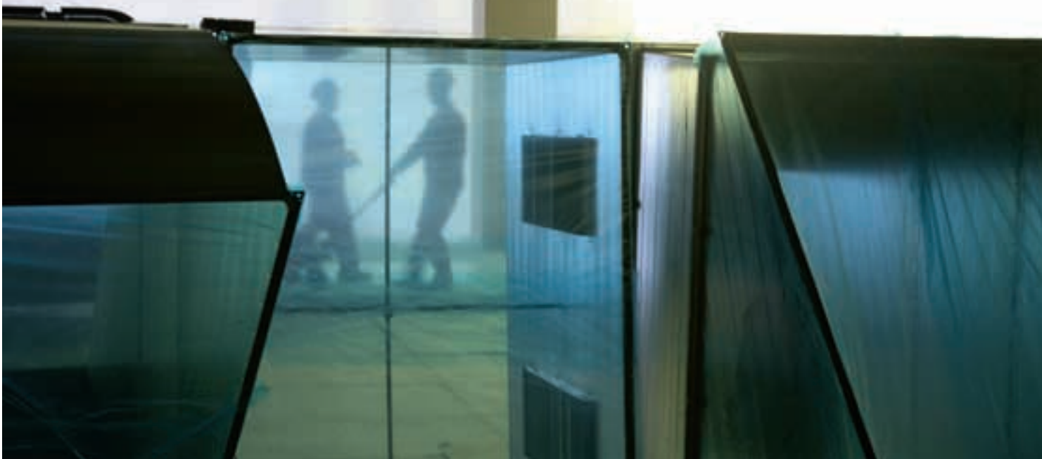
Conergy baut eine Solarfertigung im Gebäude der nie vollendeten Chipfabrik
