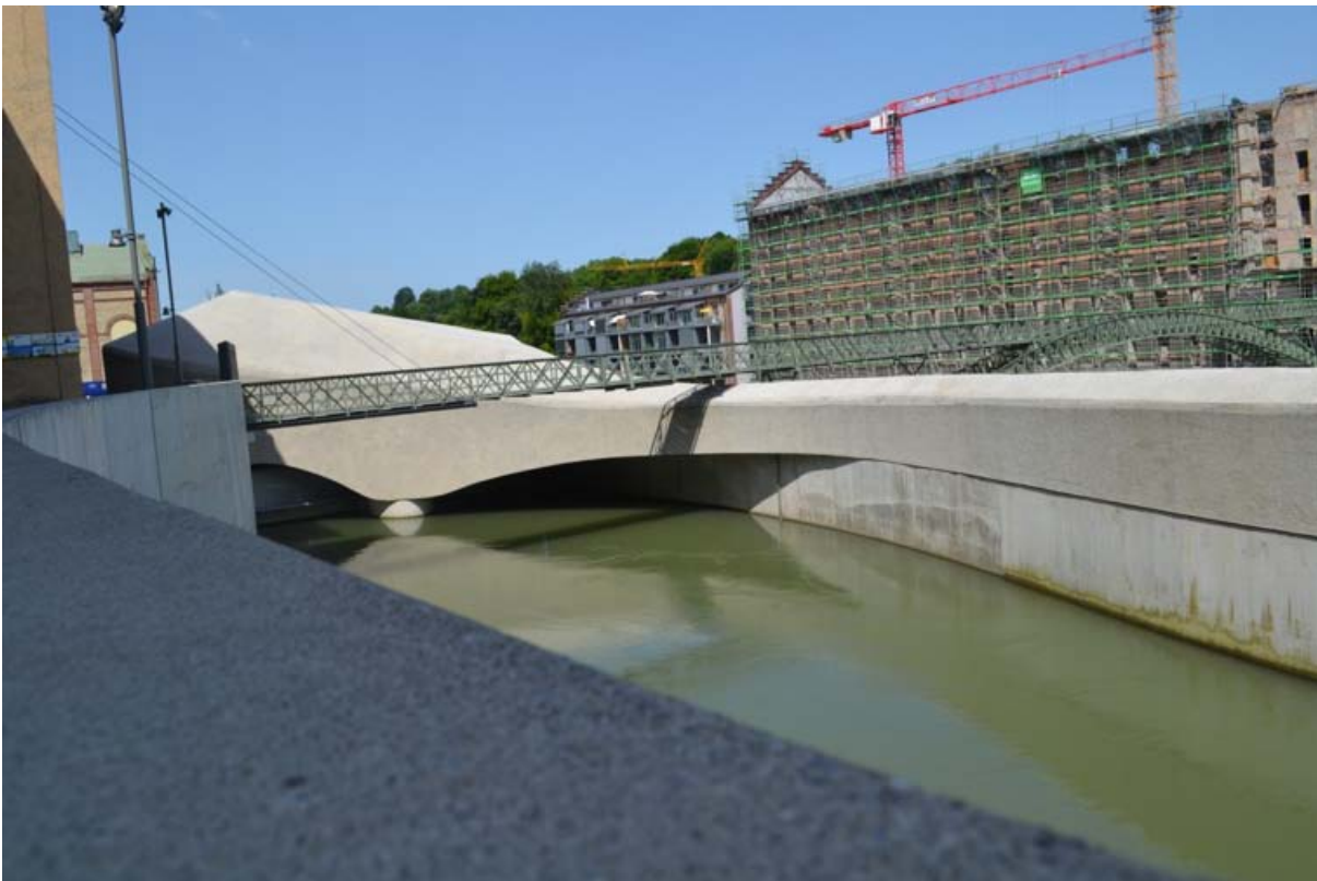
Erneuertes Laufwasserkraftwerkes in Kempten (Quelle: Agentur für Erneuerbare Energien).
