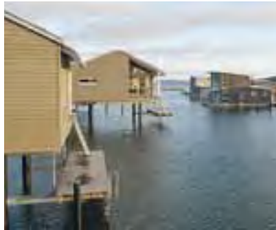
Die Wasserferienwelt im Jaich nutzt ein Biomethan-BHKW mit Nahwärmenetz.
