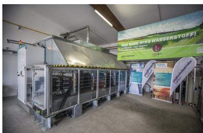
großen Stromangebots aus Erneuerbaren Energien Wasserstoff erzeugt. Der für den Wasserstoff benötigte Strom stammt aus einem nahegelegenen Bürgerwindpark und weiteren Windenergie- sowie Photovoltaikanlagen. In 1,5 Jahren konnte so eine Millionen kWh Wasserstoff erzeugt werden. Mittels firmeneigenem BHKW nutzen sie das Gas, um damit Strom und Wärme für den Mälzvorgang von Getreide zu erzeugen.
