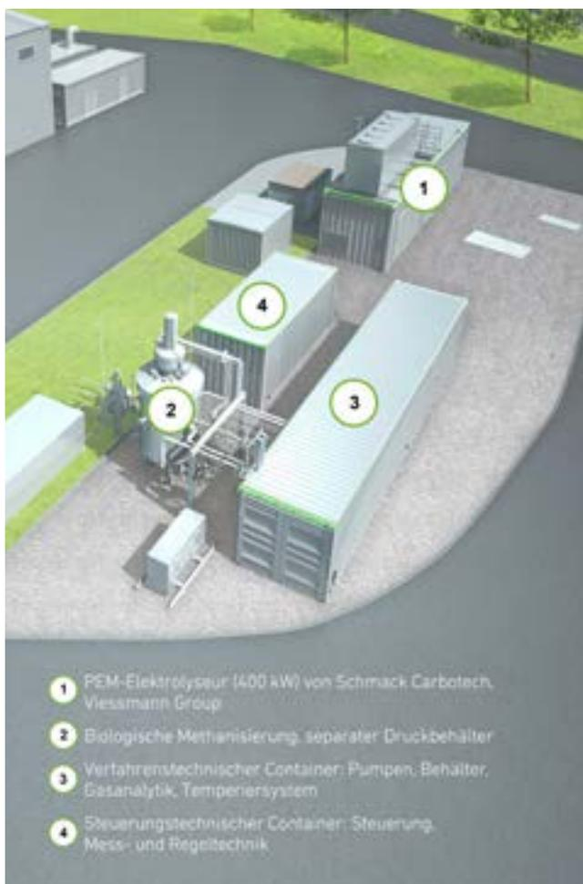
ABBILDUNG: DEMONSTRATIONSANLAGE „BIOPOWER2GAS“
