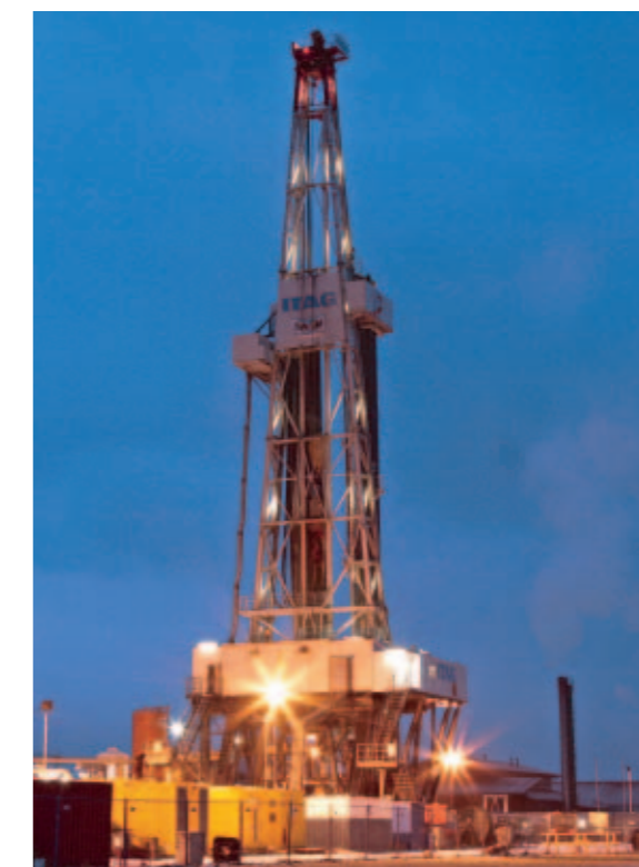
Wärme aus der Tiefe holen: Bohrung für ein geothermisches Kraftwerk in Sauerlach.
