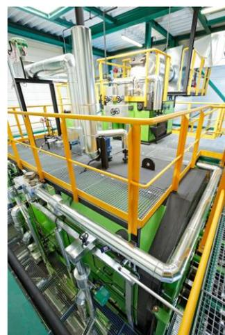
Das US Pharmaunternehmen Pfizer in Freiburg erzeugt seine Prozesswärme mittels Geothermie und Bioenergie in Form einer Holzpelletanlage, die je nach Nutzung des Kessels 5000 t CO<sub>2</sub> pro Jahr einspart. Auf diese Art profitiert der Betrieb, der über 230 Millionen Medikamentenpackungen jährlich produziert, von positiven Marketingeffekten. Die Holzpellets werden
