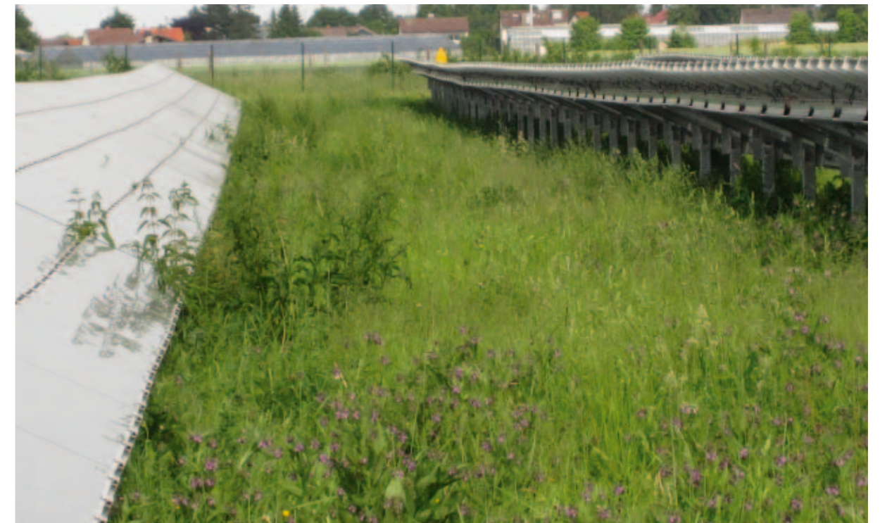
Zäune sind als sicherheitstechnische Begrenzung einerseits notwendig und sollen andererseits Kleintieren genug Platz zum durchschlüpfen geben. (Foto: First Solar GmbH)
