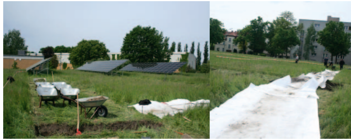
Bei den Bauarbeiten auf dem Gelände des Wasserwerks Tegel wurden zum Abtransport des Bodenaushubs Schubkarren genutzt. Aufgrund der Hochwertigkeit der Flächen wurden geschützte Pflanzen umgesetzt und zur Minimierung von Trittschäden Flächen mit Geovlies ausgelegt (rechtes Bild). (Foto: Tim Peschel)
