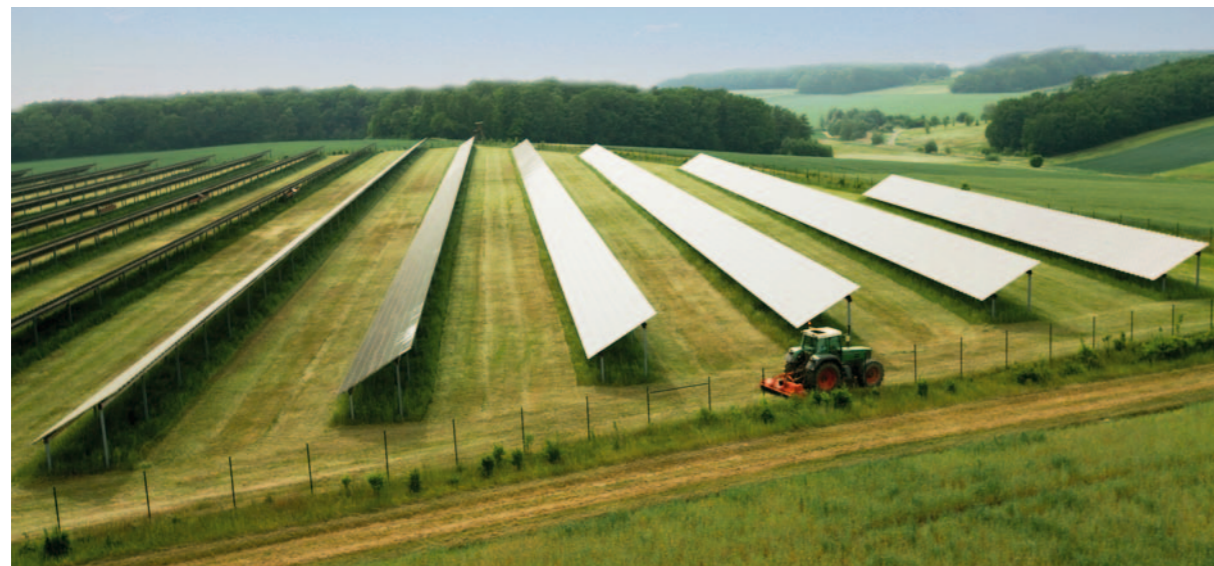
Um die offenen Flächen zu erhalten, müssen die Grünflächen um die Solaranlagen regelmäßig gemäht werden. (Foto: Blitzstrom GmbH)
