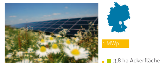
Solarpark Salmdorf Gehrlicher Solar AG, 2007 fertig gestellt
