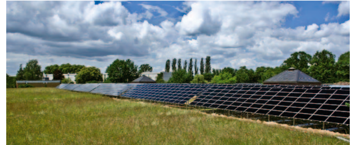
Die begrünte Dachflächenanlage auf dem Reinwasserbehälter in Berlin-Tegel bildet mit ihren geschützten Frisch- und Sandtrockenwiesen ein einzigartiges Biotop. (Foto: First Solar GmbH)
