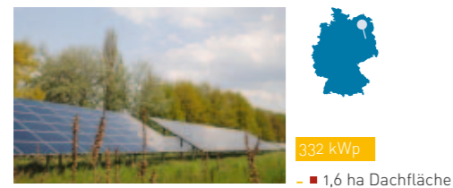
Solaranlage Wasserwerk Berlin-Tegel Solargruppe Nord (S.G.N.), 2009 fertig gestellt
