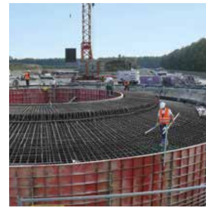
BAUARBEITEN AM FUNDAMENT EINER WINDKRAFTANLAGE
