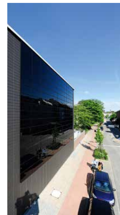
PHOTOVOLTAIK AN DER FASSADE DER FEUERWEHRWACHE AACHEN
