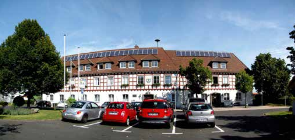
DIE SOLARANLAGE AUF DEM RATHAUS WURDE MIT DEM ENERGIEBEIRAT GEPLANT
