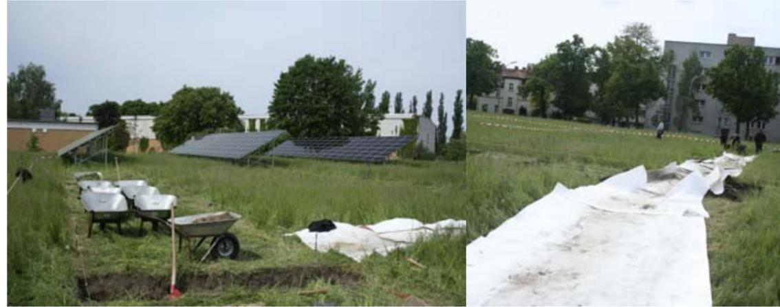
Lors des travaux de construction sur le site de l'usine à eaux de Tegel, des brouettes ont été utilisées pour le transport des terres excavées. En raison de la valeur élevée de ces surfaces, des plantes protégées ont été déplacées et les surfaces ont été recouvertes de géotextile pour minimiser les dommages dus au piétinement [photo de droite .. (Photos : Tim Peschel)]
