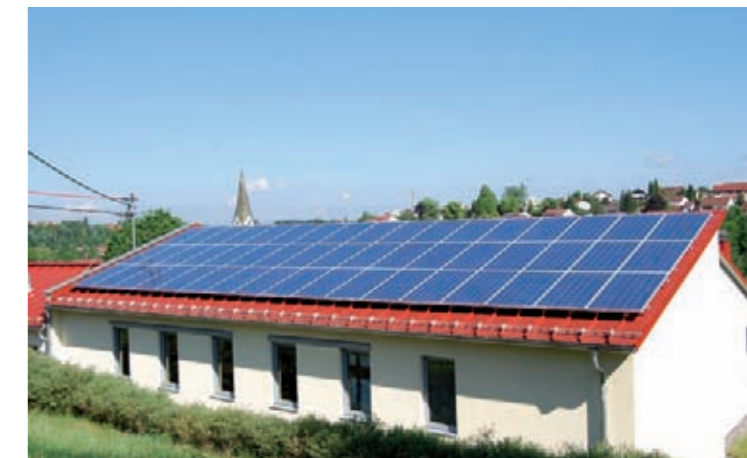
Neben dem Feuerwehrhaus stellt die Kommune noch weitere Dächer für Solaranlagen zur Verfügung.
