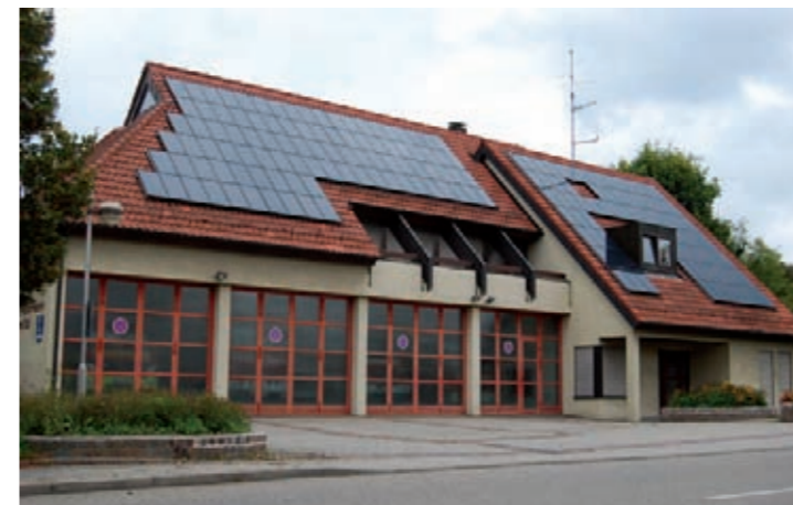
Die Photovoltaikanlage auf dem Dach der Weissacher Feuerwehr
