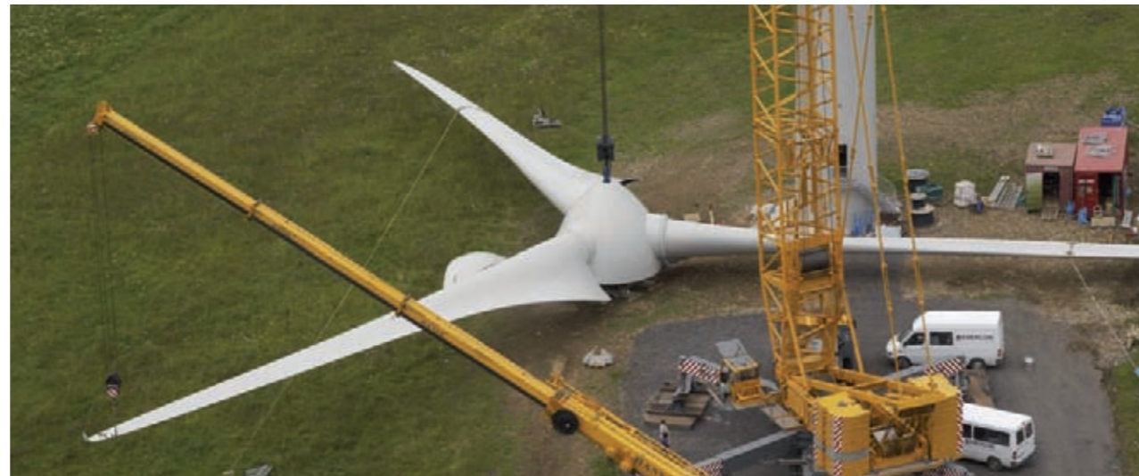
Ein Spezialkran bringt den Rotor in die richtige Position.
