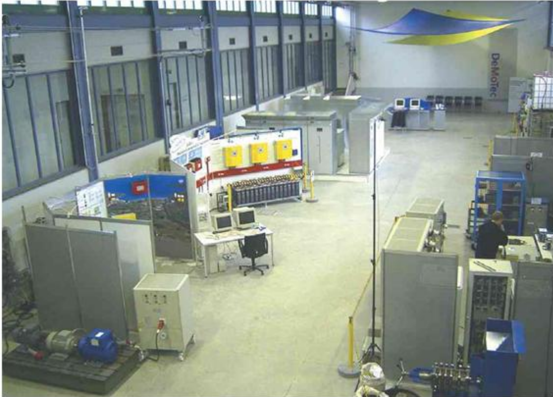
Abbildung 124: Das Design-Zentrum für modulare Versorgungstechnik (DeMoTec)
