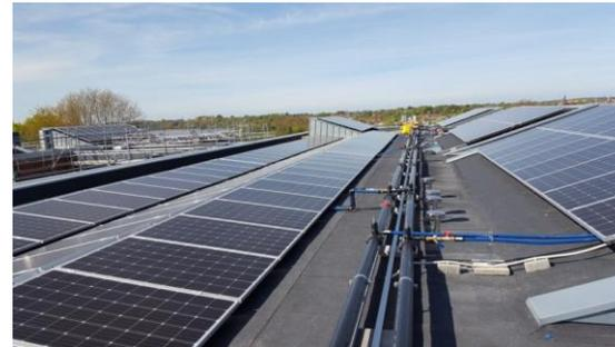
Abbildung 2: Dachabsorber unter PV-Anlage
