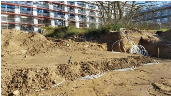
Abbildung 1: Erdkollektor in Sandwichbauweise
