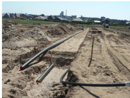
Abbildung 1+2: Verlegung Hauptleitung Kalte Nahwärme „Berender Redder“
