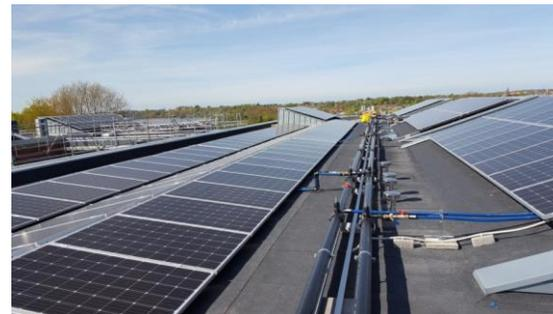
Abbildung 2: Dachabsorber unter PV-Anlage
