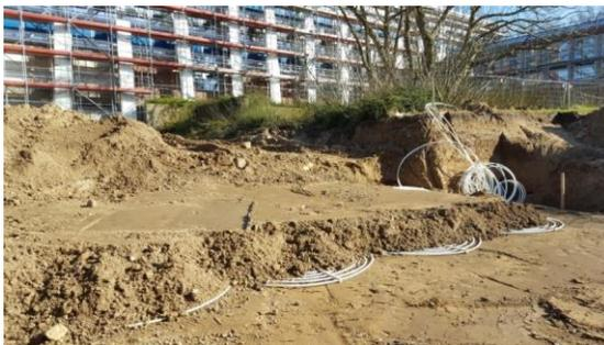
Abbildung 1: Erdkollektor in Sandwichbauweise
