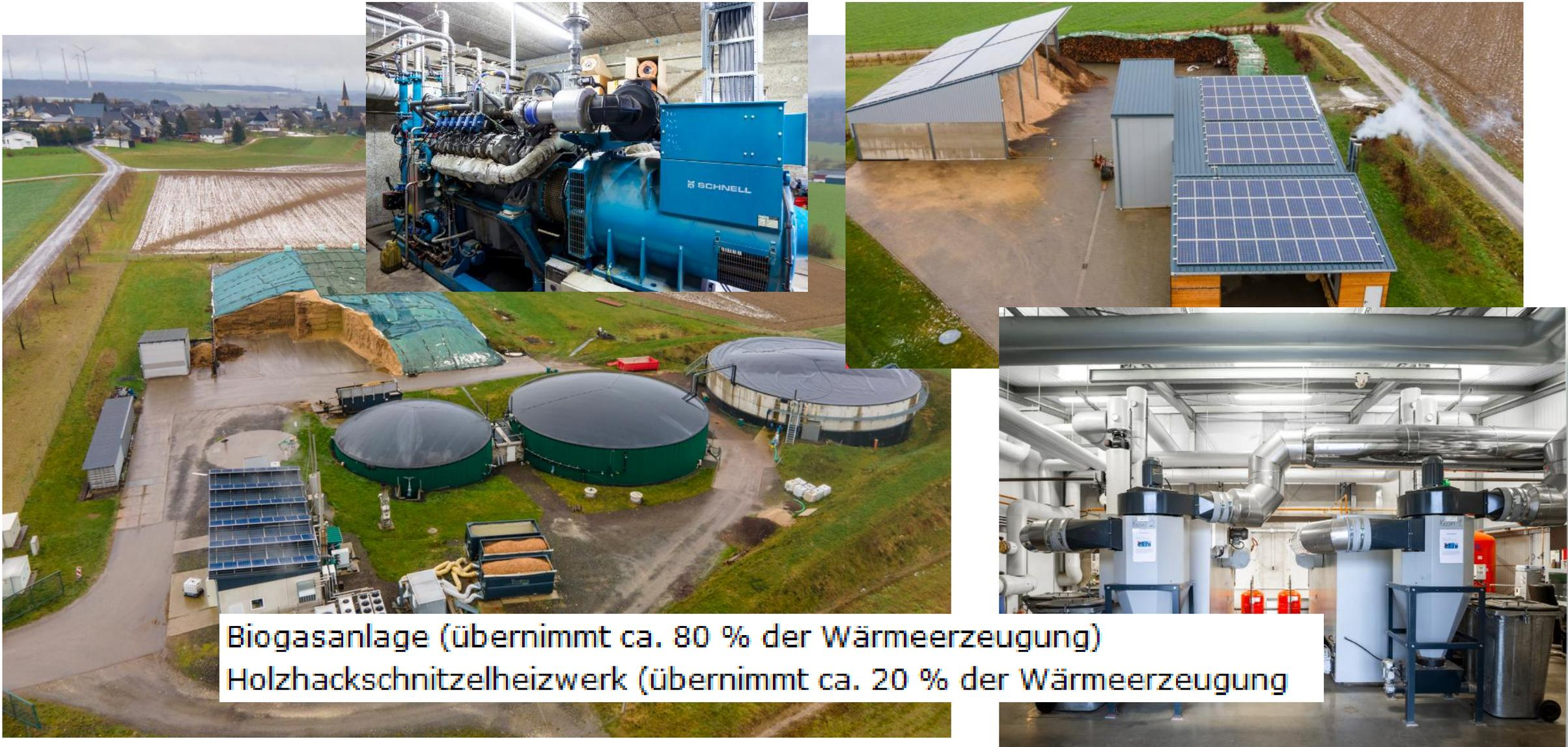
**Biogasanlage (übernimmt ca. 80 % der Wärmeerzeugung)**
