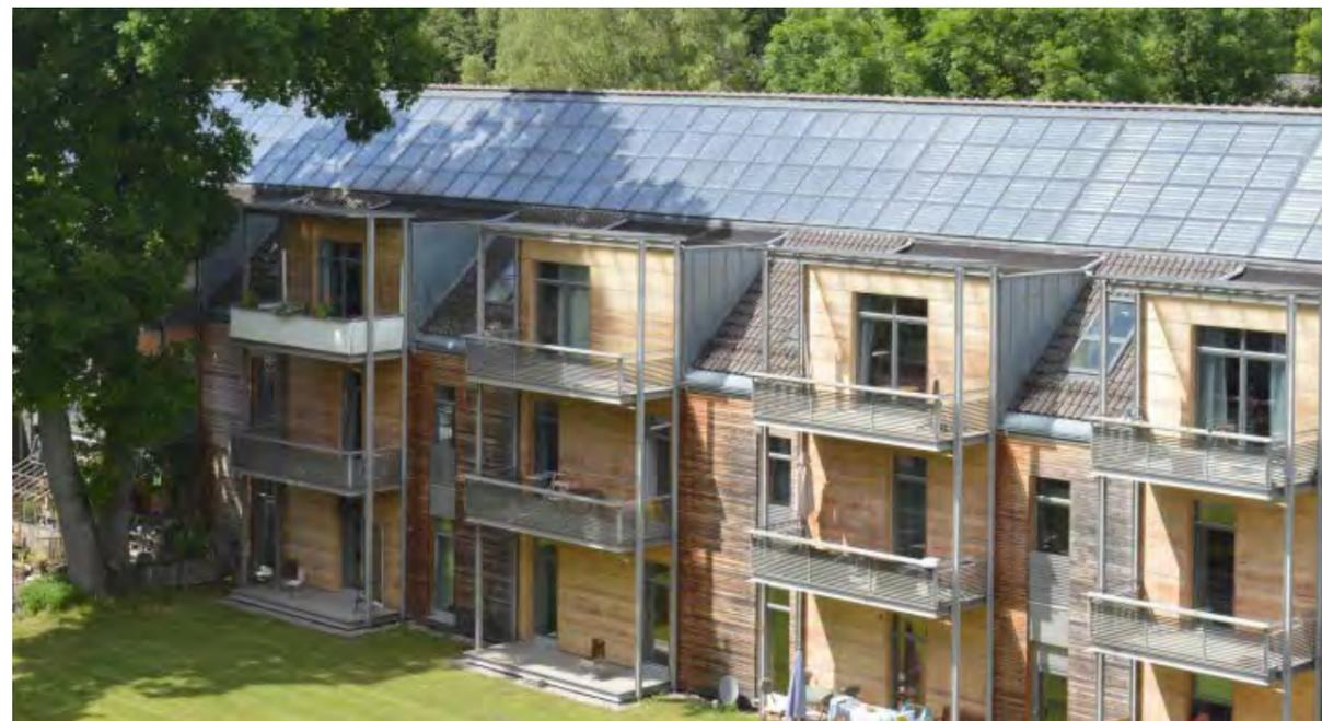
Die Neubau-Mehrfamilienhäuser sind mit einer Holzfassade und PV-Anlagen ausgestattet.
